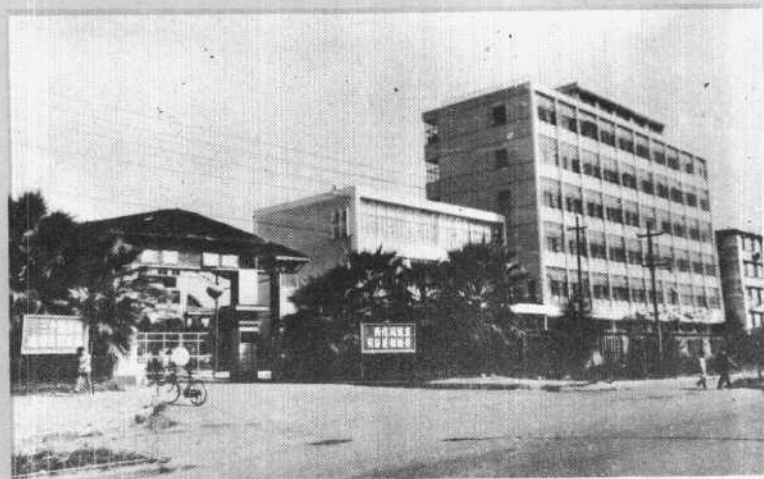
厦门新华玻璃厂（杏林）
