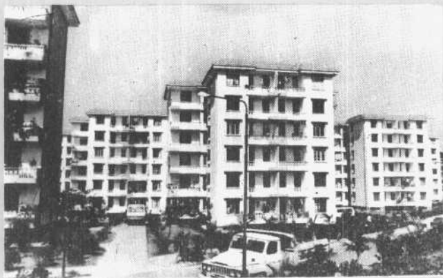
莲花新村住宅群一角
