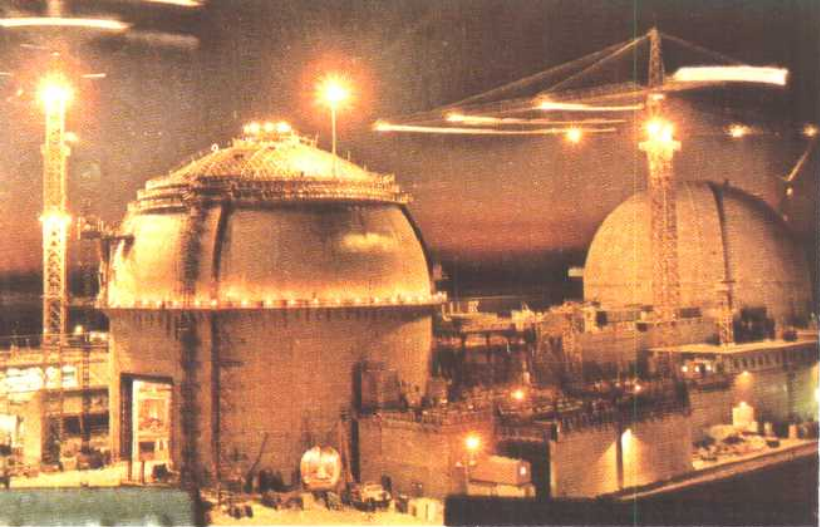
16 正在建设中的核电站 的核岛部分
