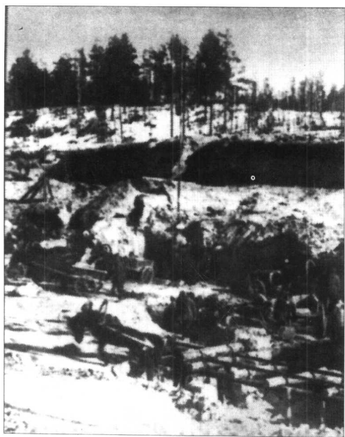
白波运河工地
