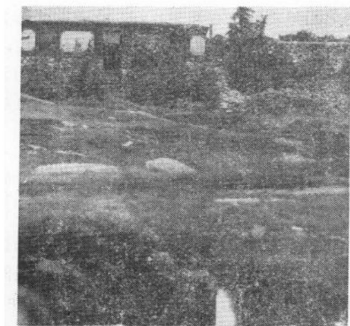
图 2 徐庄处于风化基岩的坡上建筑物破坏情况
