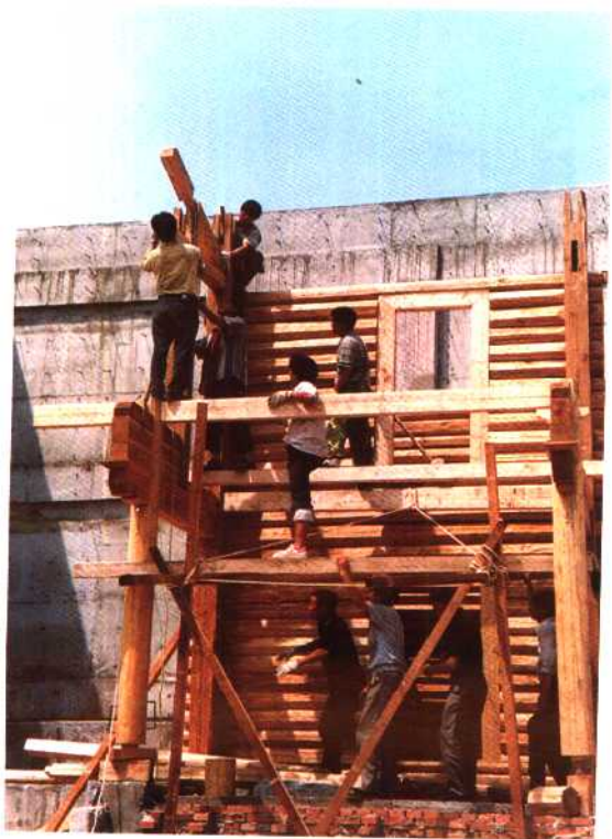
5月底,木楞房构件由加工地运往场馆地基正式安装。图为主房右侧房的安装。
