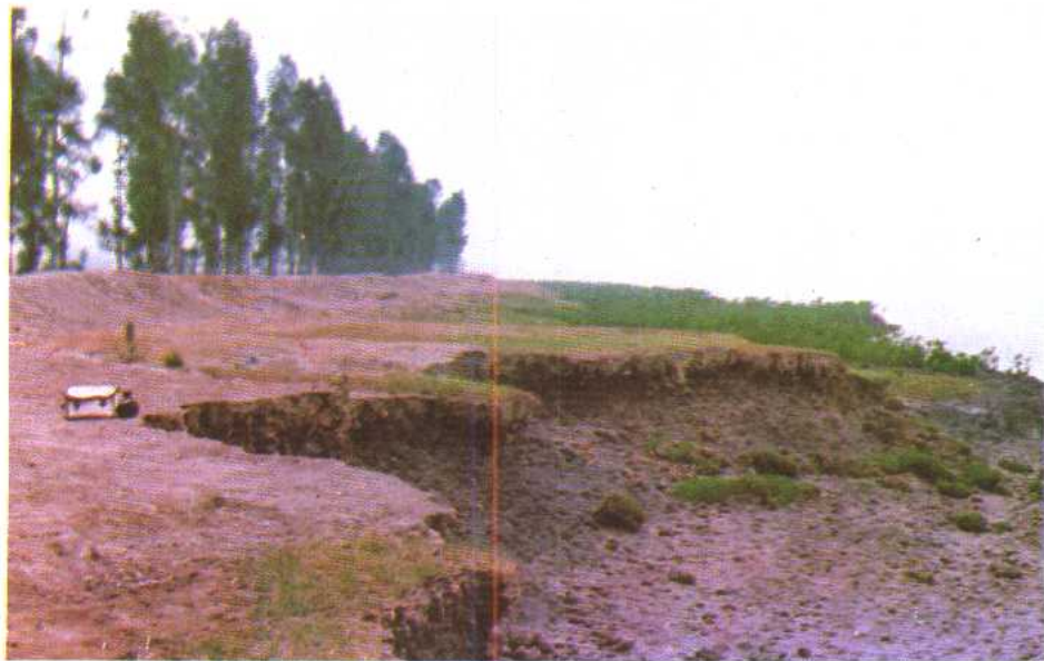
图11 砍去红树林，使海堤不断崩塌。
