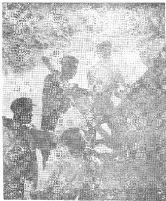
↓ 李春常同志和群众一起战斗在水库工地上
