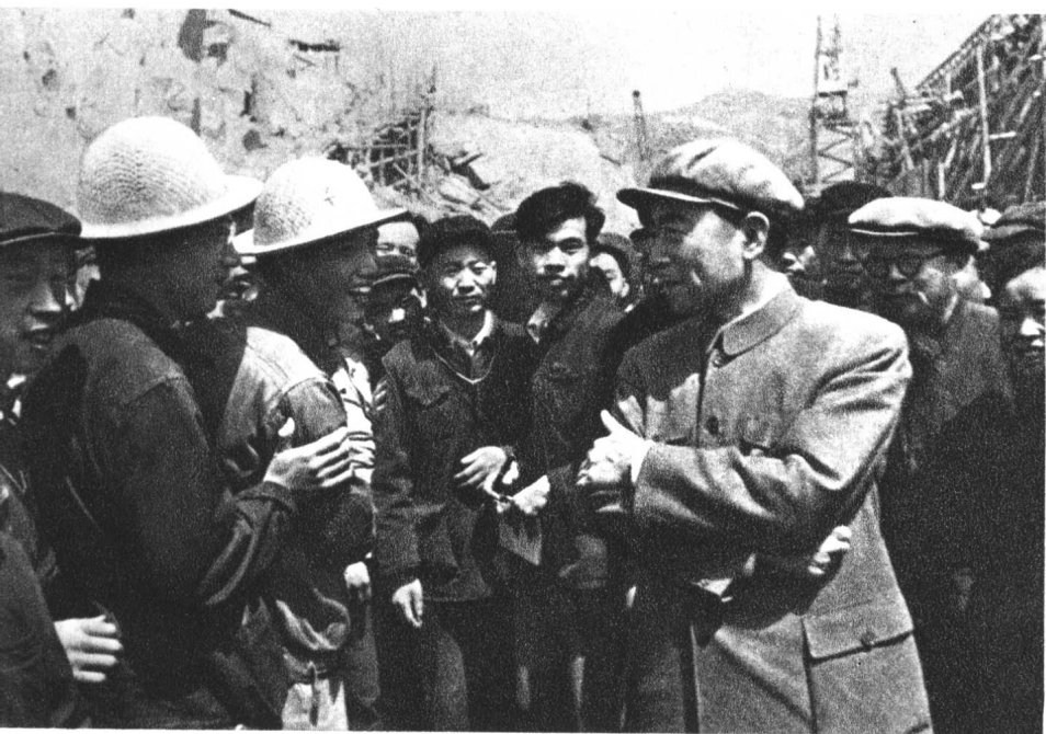
一九五八年四月二十日在三门峡工地同工人亲切交谈。
