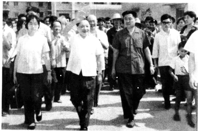
第二汽车制造厂(东风汽车工业公司)是最早试行承包制的大型汽车制造企业。图为邓小平1986年6月初视察东风汽车工业公司。
