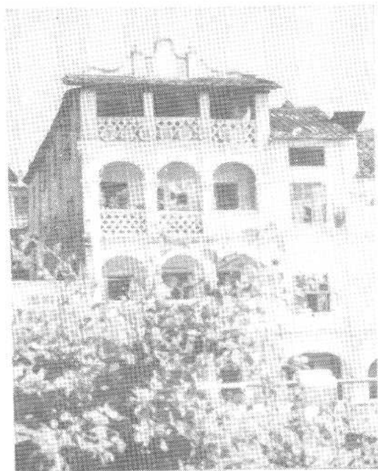
◀ 闽西工农银行旧址——龙岩城高门下井。
