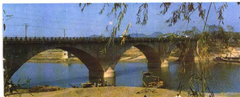
博阳河乱石拱桥
