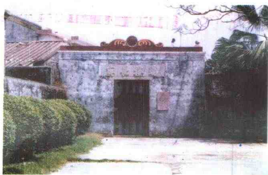
1892年孙中山和陆皓东试验炸药,将瑞接长庚闸门石块炸出一条裂缝。
