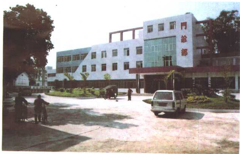
县人民医院占地面积30125平方米，总建筑面积12000平方米，医疗用房8186平方米，拥有CT、脑电图机、超声波机、微波针灸机、心脏急救机、高压氧仓等一批现代化先进医疗设备，图为门诊部大楼。
