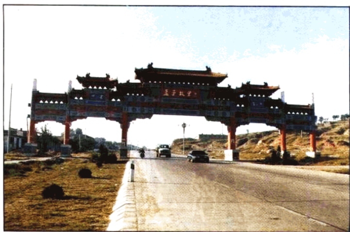
孔孟新道(京福 104 国道邹曲段)新建大型仿古跨路彩坊
