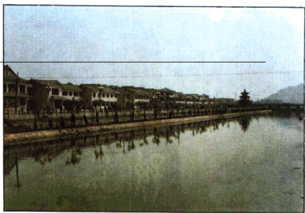
综合改造治理后的南沙河与孟庙孟府开发区建筑群
