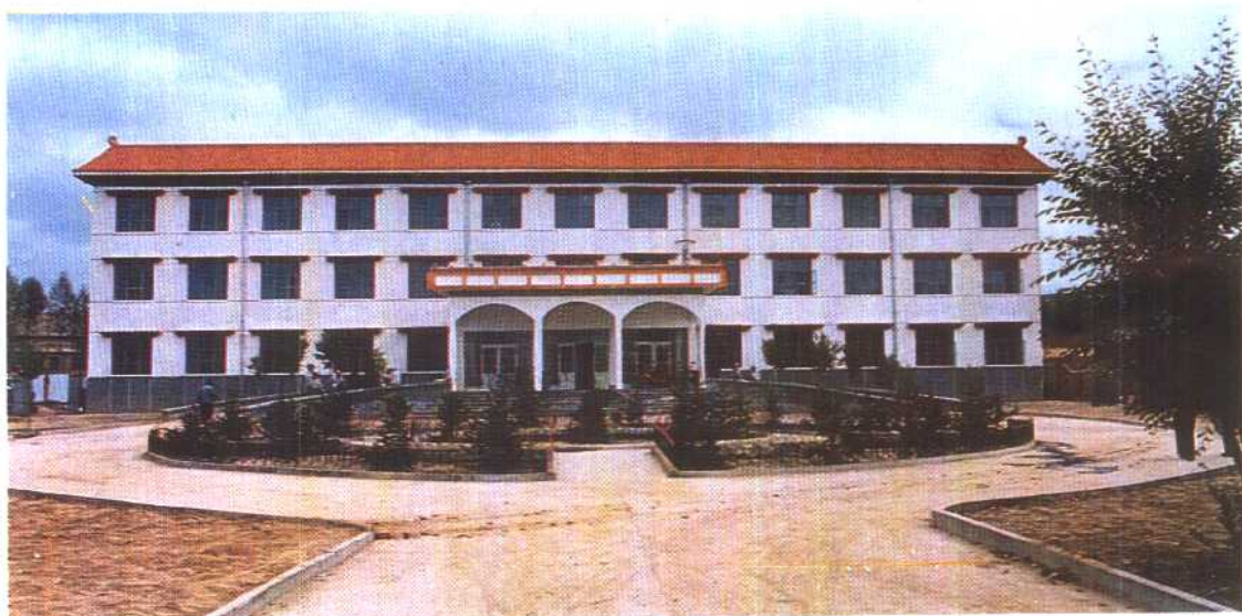
县中医院住院部
