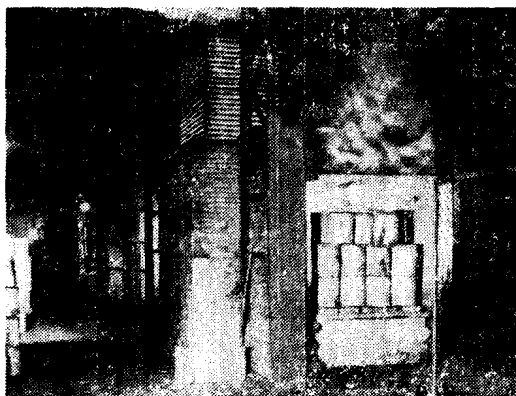
图4 隧道窑的局部外形
