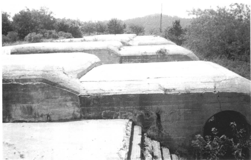
旅顺口威远炮台
