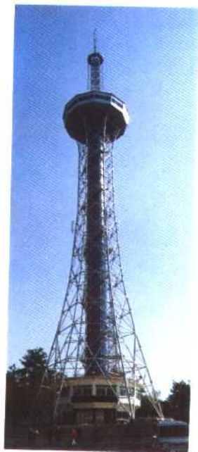
◀ 龙川县广播电视塔
