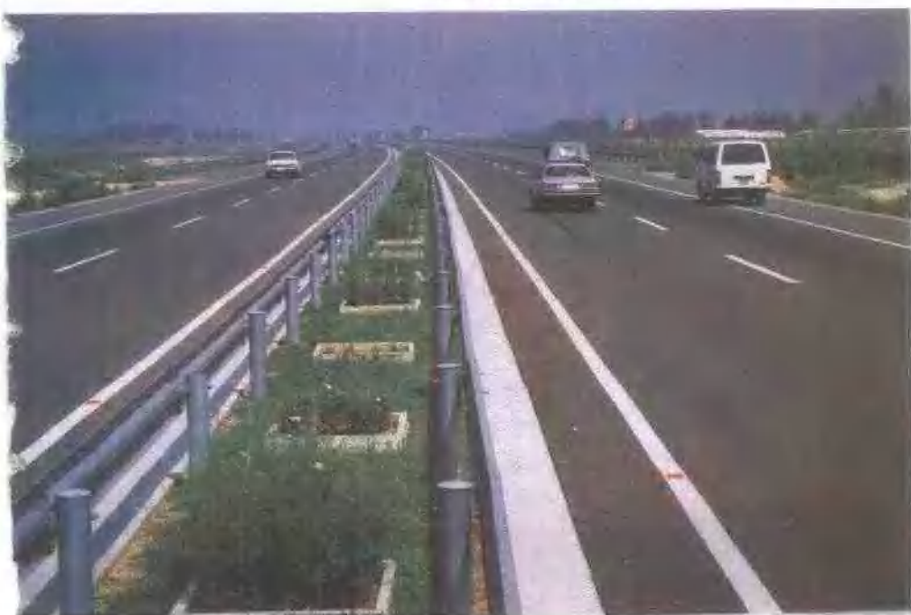
贯穿河北的京深高速公路 钟晓勇摄
