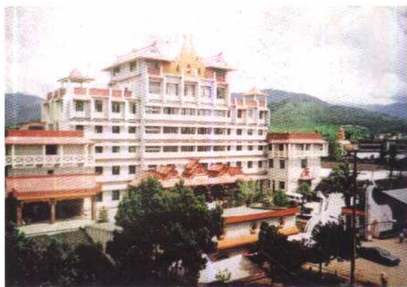
今日州民族医院门诊大楼
