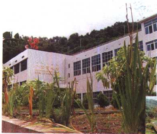
户宋河电站机房
