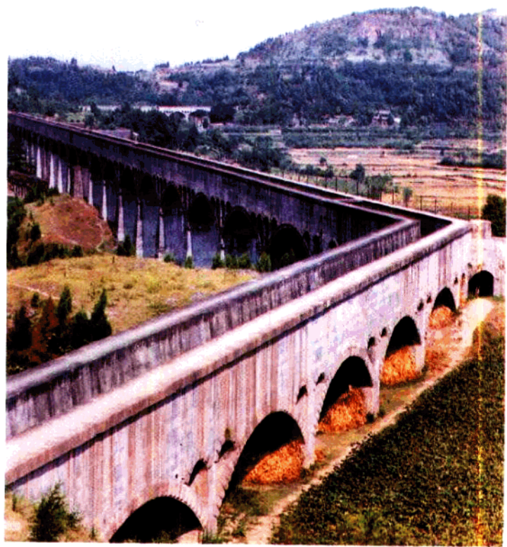
座落于射洪县太乙镇境内的人民渠帽匠桷渡槽
