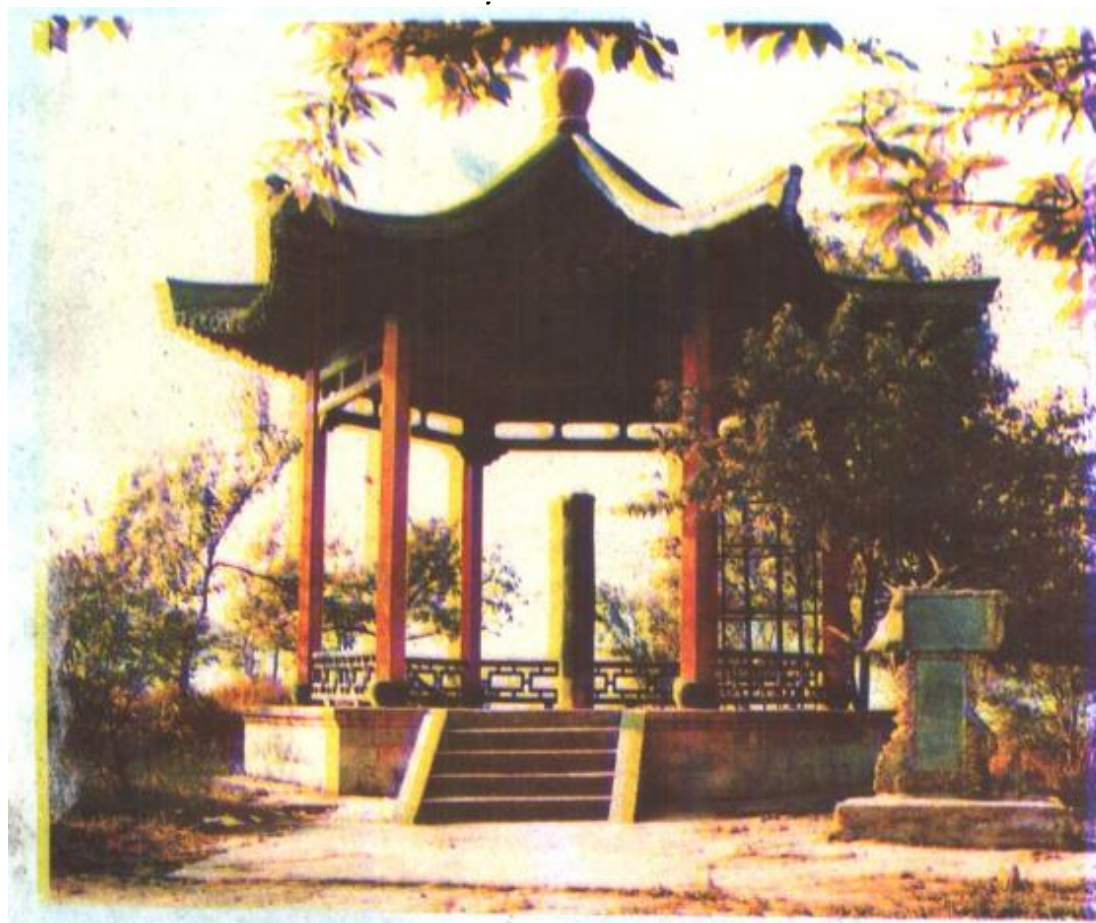
溪州铜柱 后晋天福四年（公元 939 年）楚王马希范与溪州刺史彭世愁战，次年双方签订盟约，于会溪坪“立铜柱为界”。柱高 3.98 米，重约五千余斤，柱身为八方体，盟约镌刻其上，虽历千载，字迹犹存。此柱现移至永顺县王村镇，系全国重点保护之文物。
