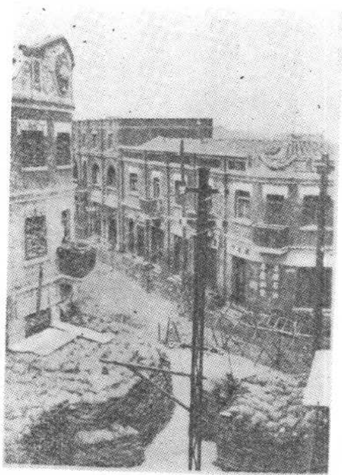
日租界街头构筑工事情景
