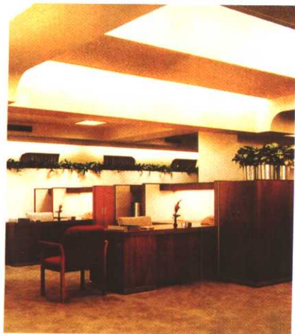
图 2.3-34 采用间接照明的办公室外观
