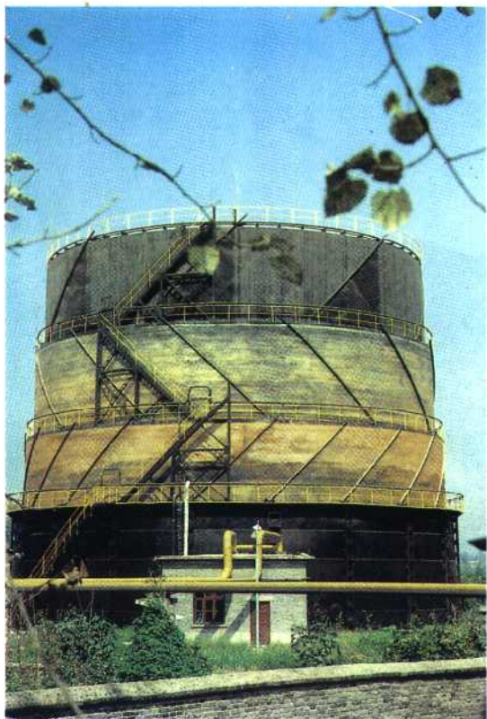
图5-10 南阳酒精厂的 10000 米 3 沼气贮气柜 (上)和杭州浮山农场的大 型沼气装置(下)
