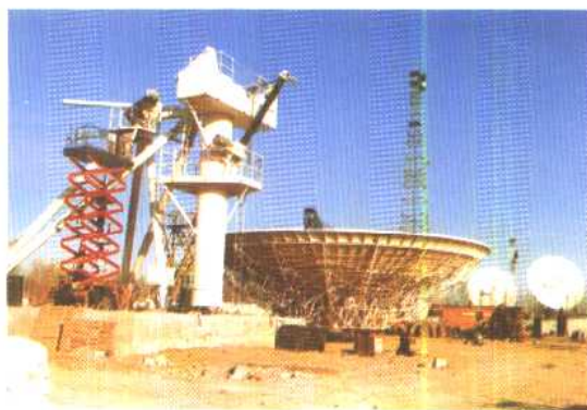
正在建设中的北京 国内卫星通信 5 号地球 站。
