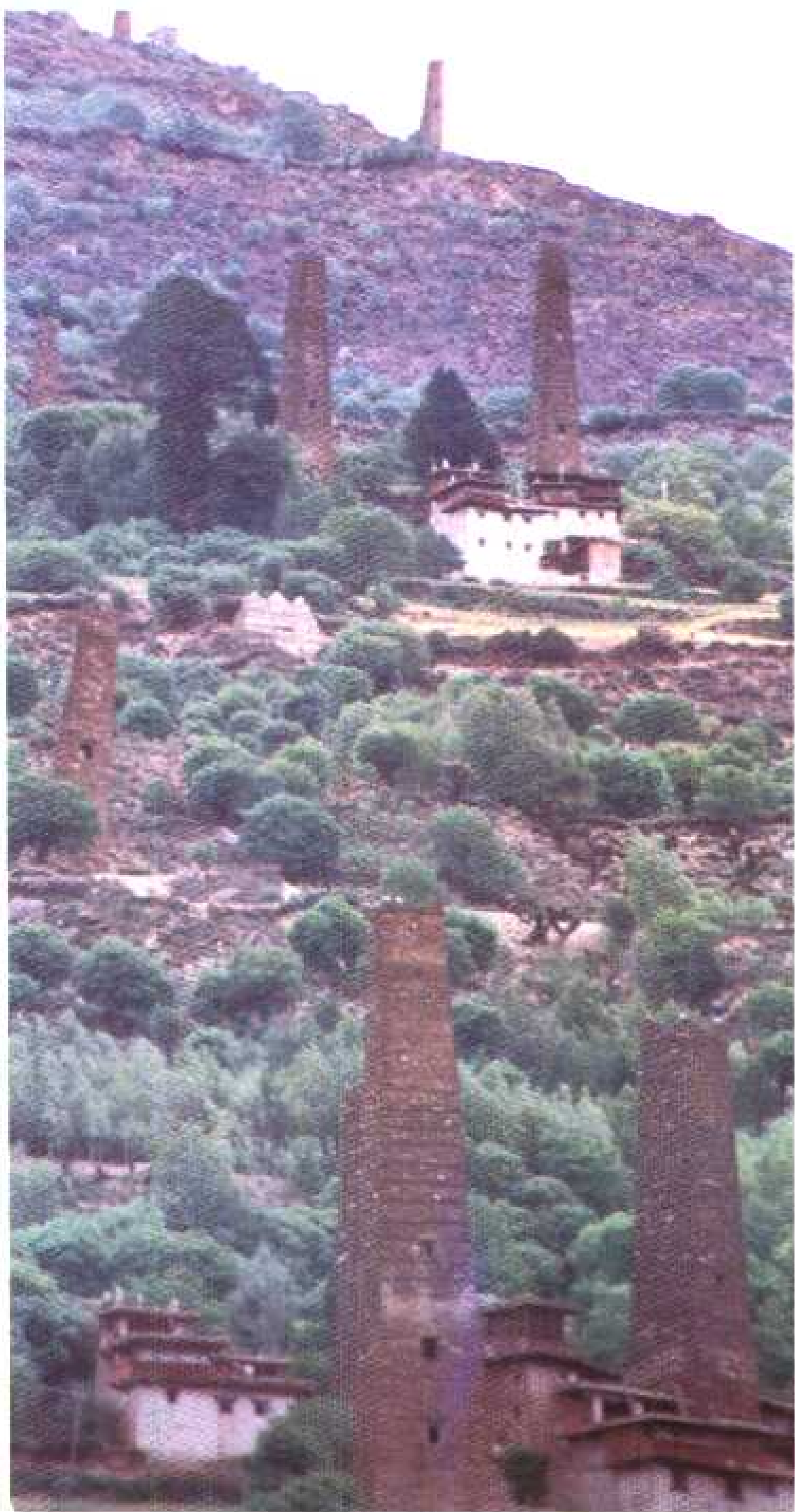
丹巴梭坡碉寨一角
