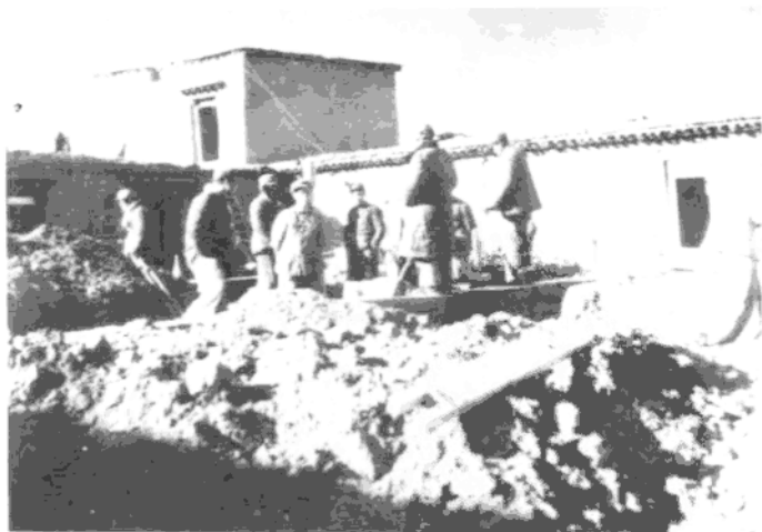
◀ 昌都地区人民医院医务人员自己动手，挖土盖房（1952）。
