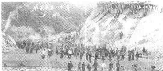
屏南县五八水库工地。
