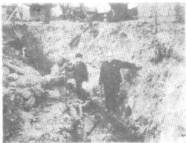
照片 4 埋在地下约2米的古建筑基础
