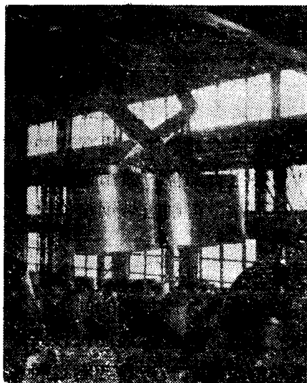
图 2 自动吊钳吊钢卷的情形
