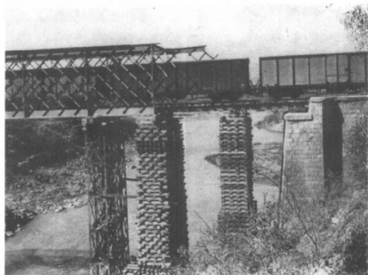
昆河铁路(滇越铁路)小龙潭桥被日机炸毁后,抢修队以枕木垛、钢塔梁、束轨梁抢修通车。(摄于1940年5月)
