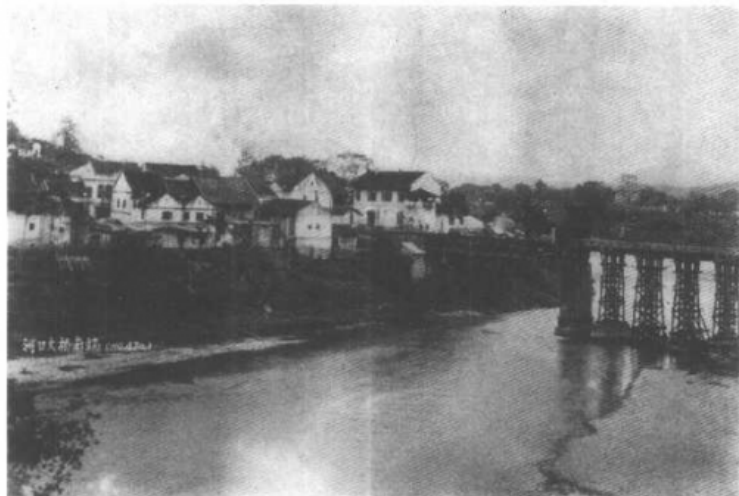
1940年8月,为防止日军进犯云南,将河口桥破坏。1946年末,以木排架及工字钢梁将桥临时修通。
