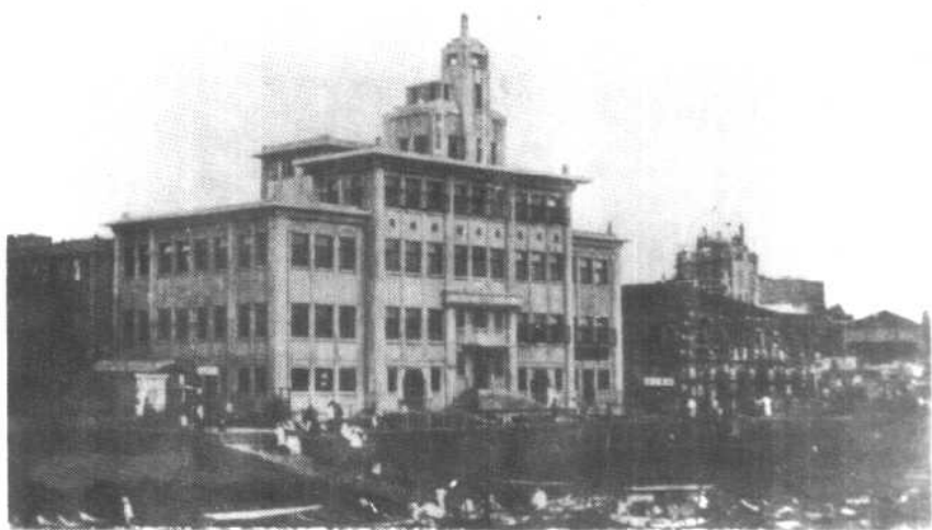
二十年代华侨投资的厦门自来水公司 办事处（上）和厦门电灯公司发电厂（下）。
