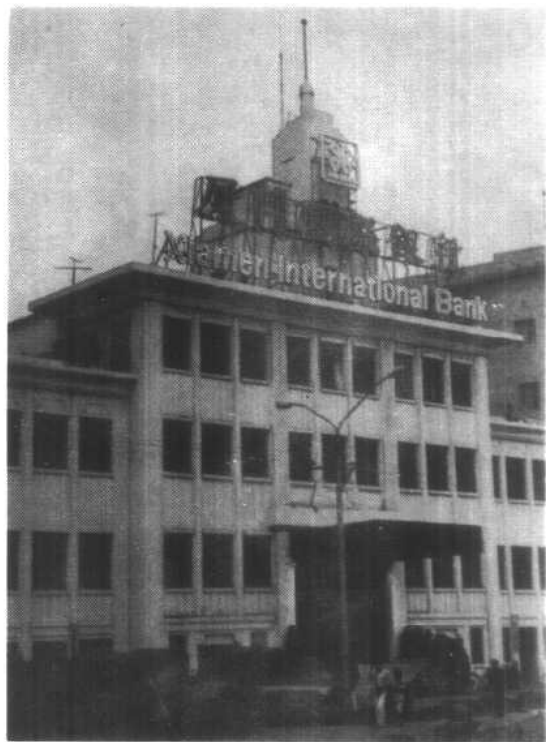
中外合资厦门 国际银行办公大楼。
