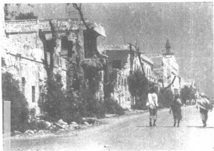
摩加迪沙城“绿线”附近的建筑大都千疮百孔，整条街巷成为“鬼城” 王继雨 摄
