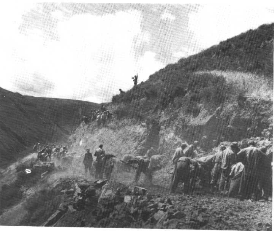
热火朝天筑“金桥”
