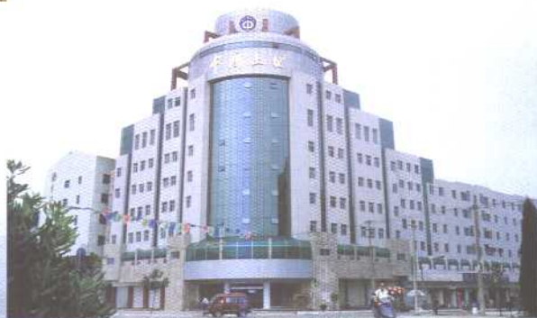
国土局办公大楼
