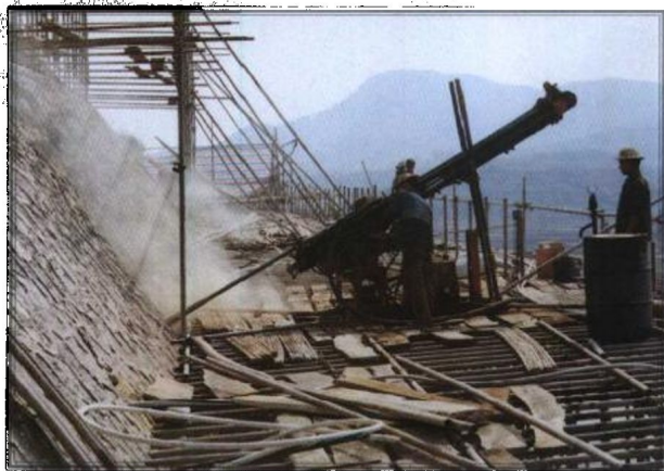
广西地勘局桂林地勘院利用特有技术对桂柳高速公路的滑坡进行锚固治理
