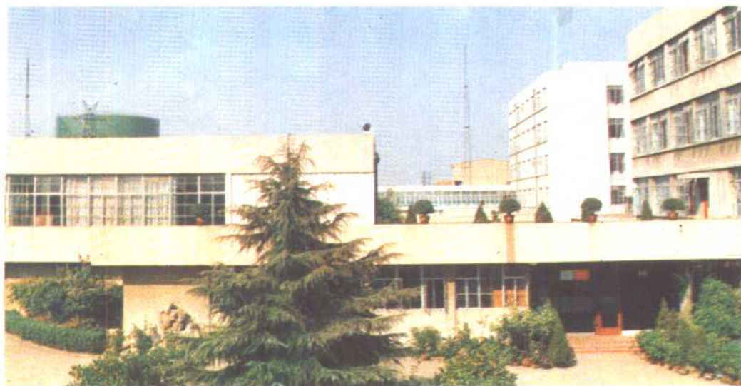
一个靠改革起家、走自力更生道路、取得显 著效果的研究所——这是常州化工研究所用自 筹资金建造的7000多平方米的科研和测试建筑 群落。
