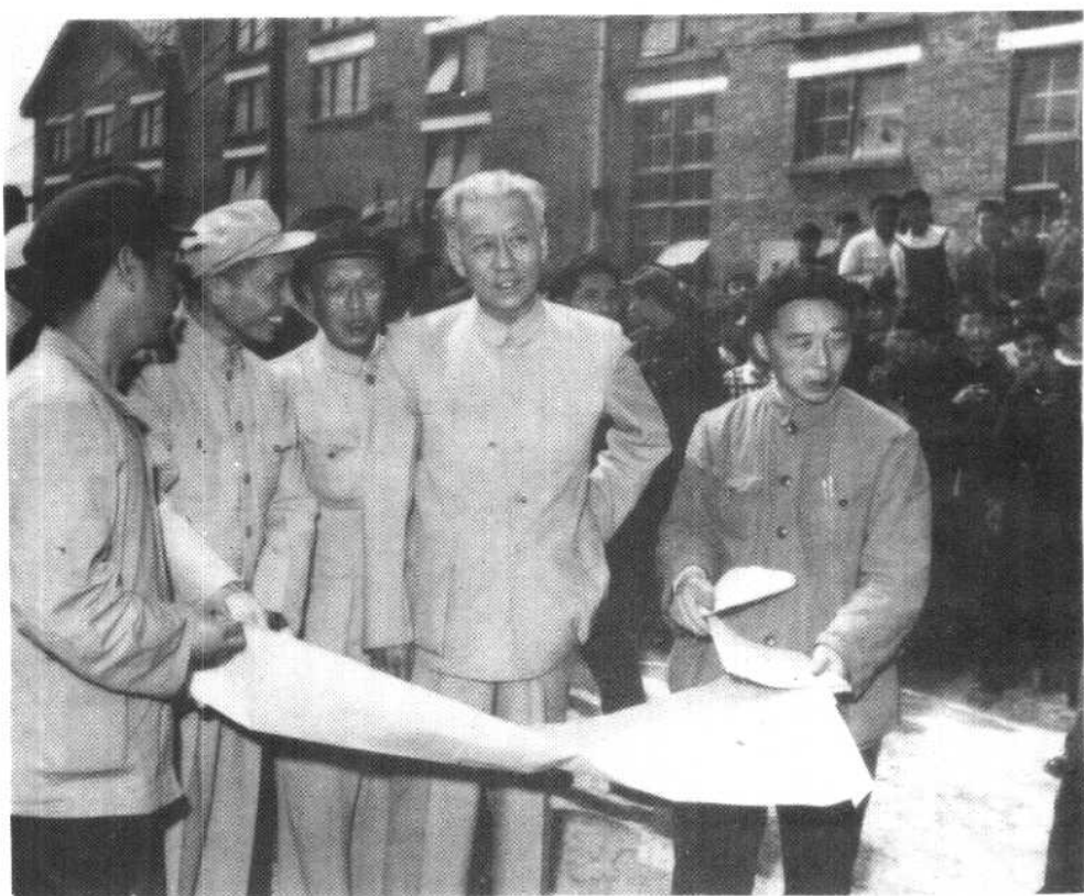
刘少奇在四川德 阳建筑工地视察 (1960年) 新华社稿
