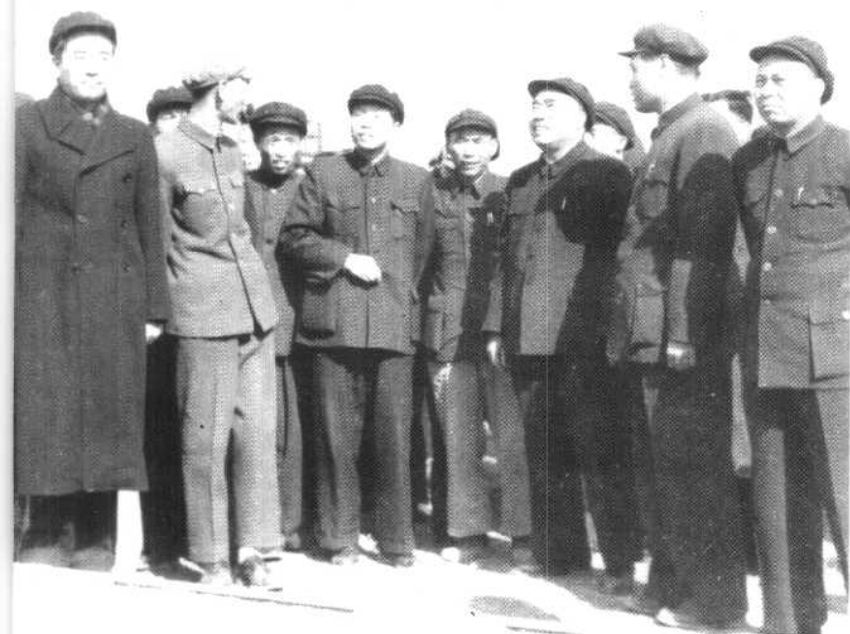
朱德视察富拉尔 基重机厂工地 (1957年)
