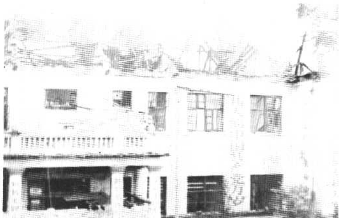
图19 同上 述时间区林业厅 有一栋宿舍亦被 炸毁。
