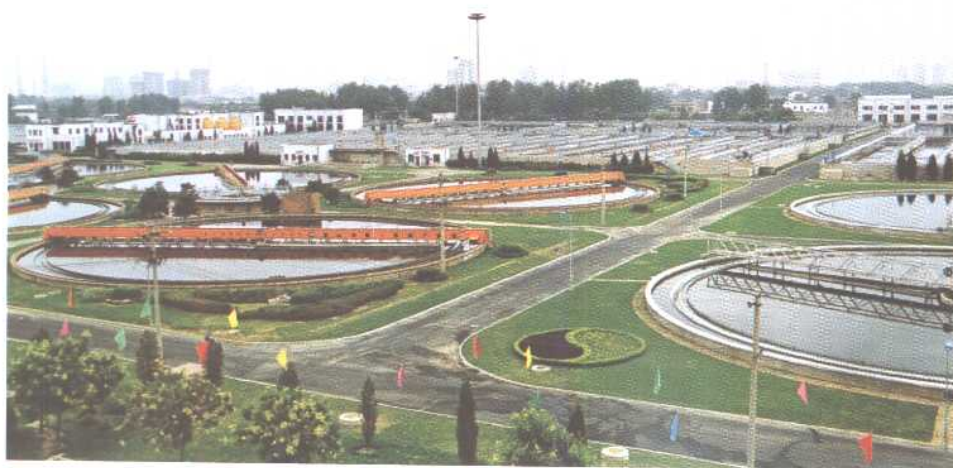
为适应北京成为国际型大都市的发展需要,北京市于1990年起投巨资兴建高碑店污水处理厂,它将对改善北京市的水环境,缓解日趋紧张的水资源起到巨大作用。1993年底一期工程建成运转使用,日处理污水80吨。二期工程在1999年建成投入使用 (邓佳 韩世华 摄)
