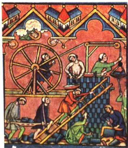
工筑施工情景。选自大约1250年作的一本插图的法文本《圣经》。请注意踏板和踏板上的轮子、绳子和滑轮：利用这些轮子、绳子和滑轮把装满石头的篮筐提到施工平面。（摩根图书馆）
