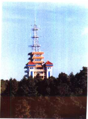
紫溪山通信枢纽楼 ▷
