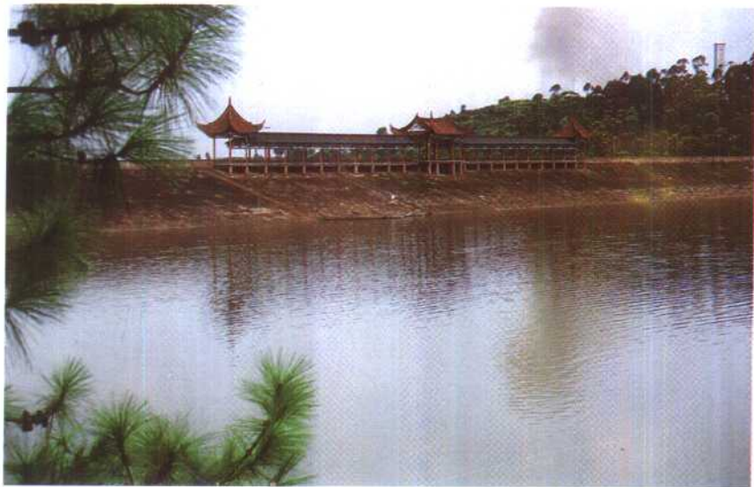
东风水库 大坝
