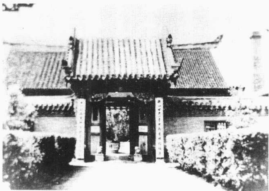
清代宁古塔满族富人家住宅
