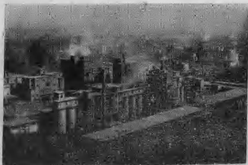
北流县水泥厂外景
