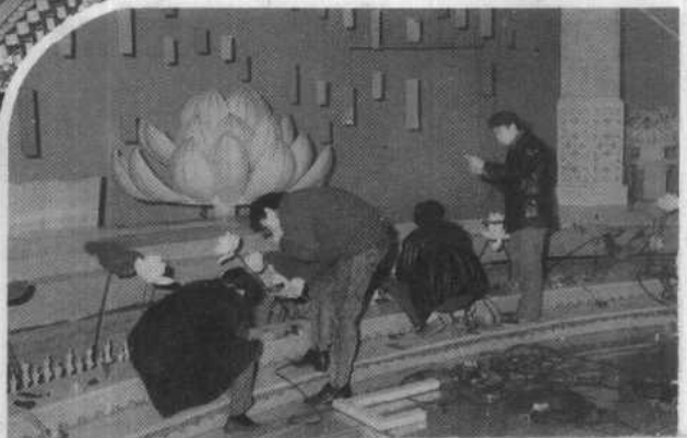
照明师在安装场景灯光设备
