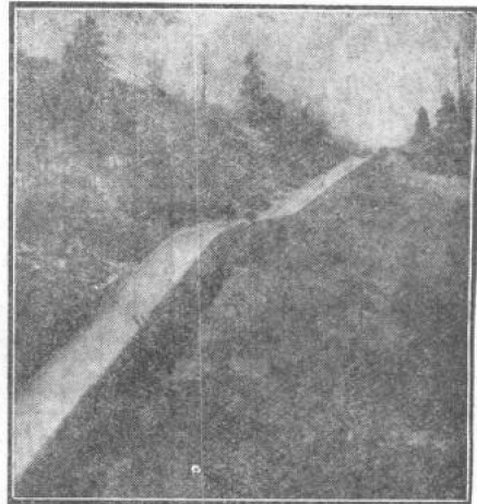
圖 3. 在坡度突變處, 水流離開槽底 (帽溪陡槽, Q=395 立方呎/秒)
