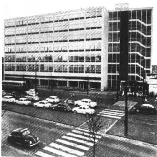
大学办公大楼
