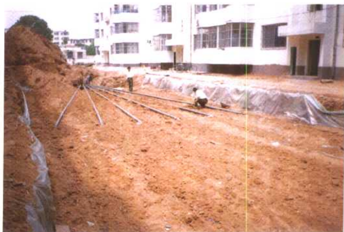
沈阳应用生态研究所的地下渗滤工程是城市污水处理的革新 / 替代技术,基建费用低、再生水质好,水回收率可达 70%。图为沈阳茨榆坨采油厂宿舍区工程现场。
